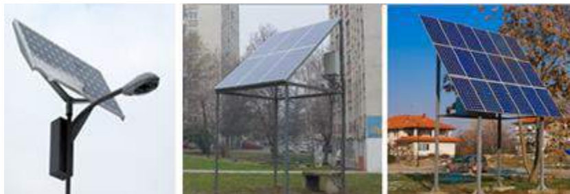
Слика 56. Улично осветлување со соларен панел (лево) Фотоволтаици (десно)
